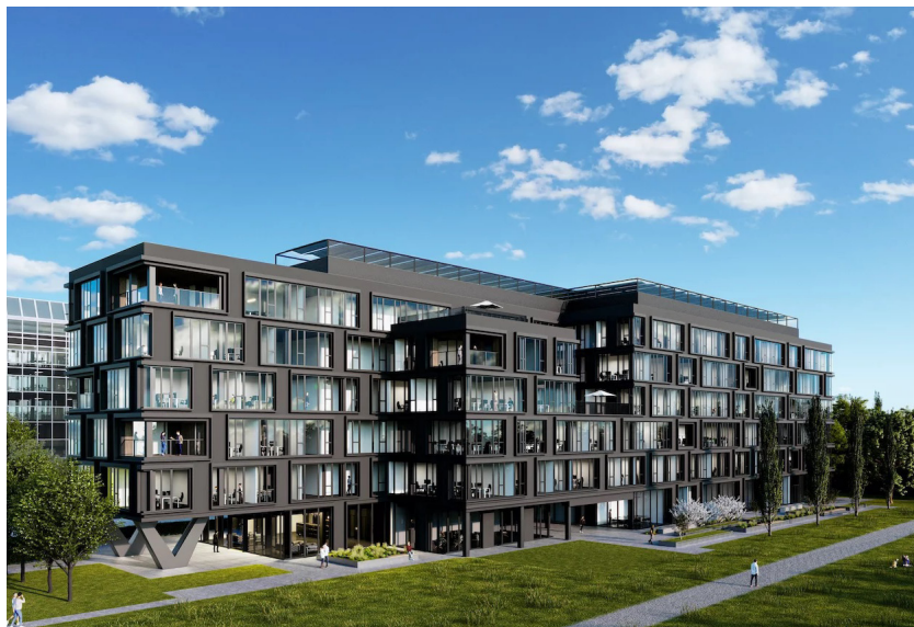
Projektentwicklung „H29“, Hansastrasse München, 11.593 qm, ca. 58 % der Mietflächen an einen Ankermieter vor Fertigstellung 2024 vermietet.
